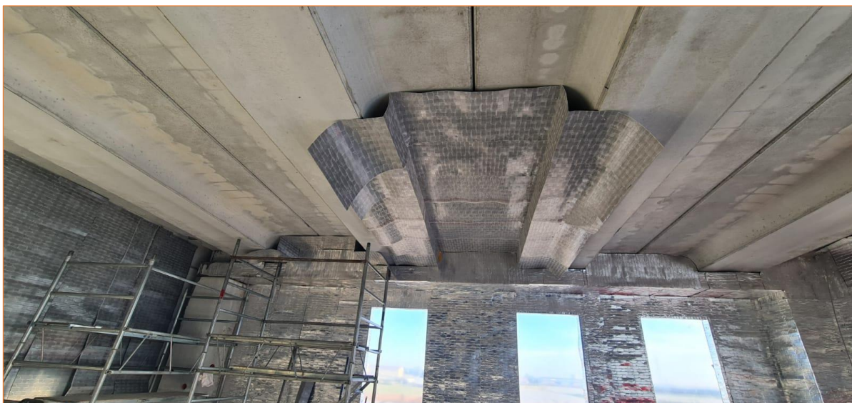
Fig. 2 Sistema G-iron AFH™ su intradosso
