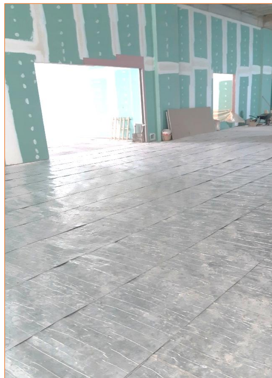
Fig. 2 Posa sistema G-iron ArmoFlex® a pavimento
